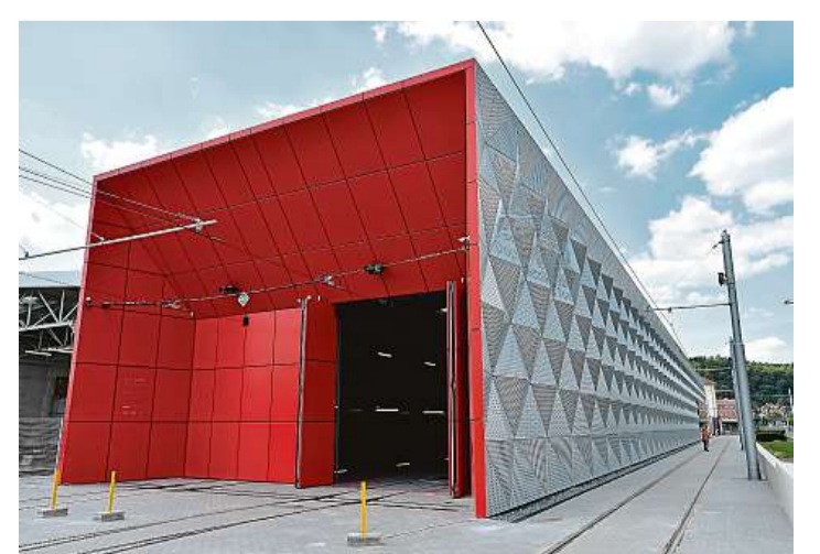
Moderna Nová hala v pisárcecké vozovně v noci mění barvy a zároveň pohlcuje hluk projíždějících tramvají linky číslo 1.
